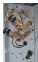
V4 - Válvula de 4 vias para sistema de 4 tubos
